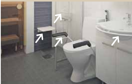
Pesualtaan kiinteä tukikaide, suihkuistuin, tukikaide suihkussa ja wc-istuimen kyynärtuet.
