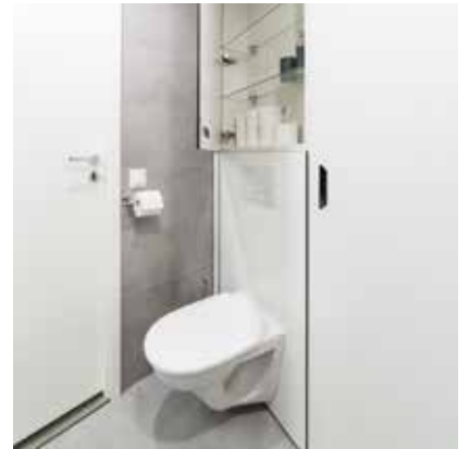
Seinään kiinnitetty wc-istuin.
