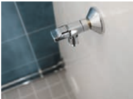
Предусмотренные места для подключения стиральных машин
