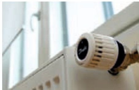
Радиаторы PURMO с терморегуляторами DANFOSS
