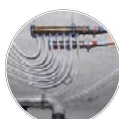
Разводка скрытая, доступ через лючки
