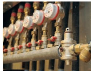
Счетчики расхода холодной и горячей воды
