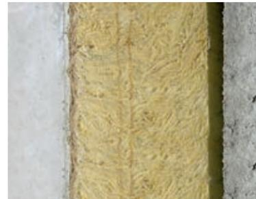
Утеплитель наружных стен из минеральной ваты
