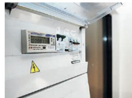
Двухтарифные счетчики и устройства защитного отключения
