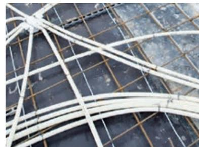
Разводка системы отопления лучевая коллекторная, горизонтальная, трубы отопления спрятаны в перекрытиях.
