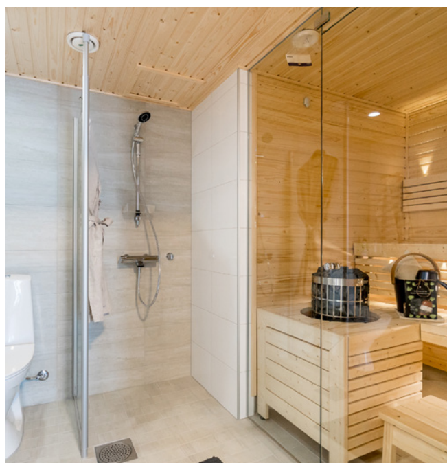
Pesuhuoneen ja löylyhuoneen lasinen väliseinä tuo ylellistä tilan tuntua. Saunan paneelit ja lauteet ovat kuusta (1.–8. kerroksen asunnoissa) tai tervaleppää (9.–14. kerroksen asunnoissa). Laudetasoon upotetun pilarimallisen sähkökiukaan säätimet on asennettu kätevästi saunan seinään.
