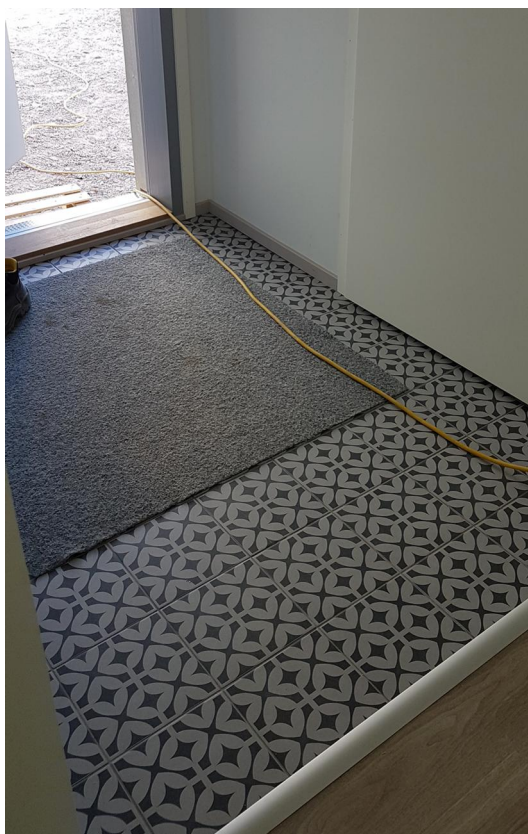
Kuva viitteellinen. Kuva aiemmin valmistuneesta YIT-kodista.
